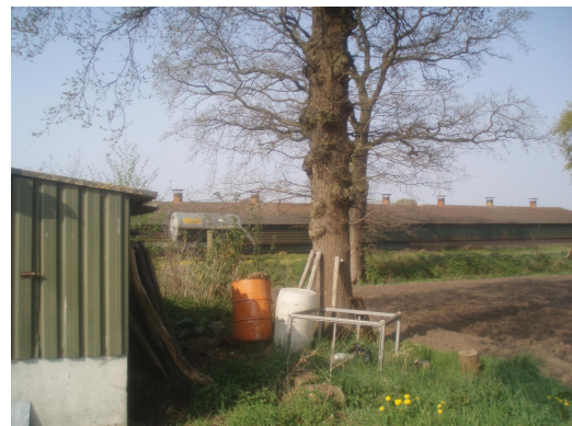
Foto 1 kippenschuur die gesloopt wordt.
