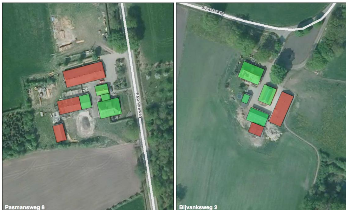
Afbeelding 3.1 Te slopen bebouwing beide locaties (Bron: BJZ.nu)
