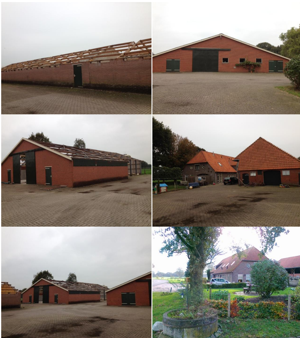
Figuur 2: enkele foto's van het plangebied aan de Raalterweg te Holten
