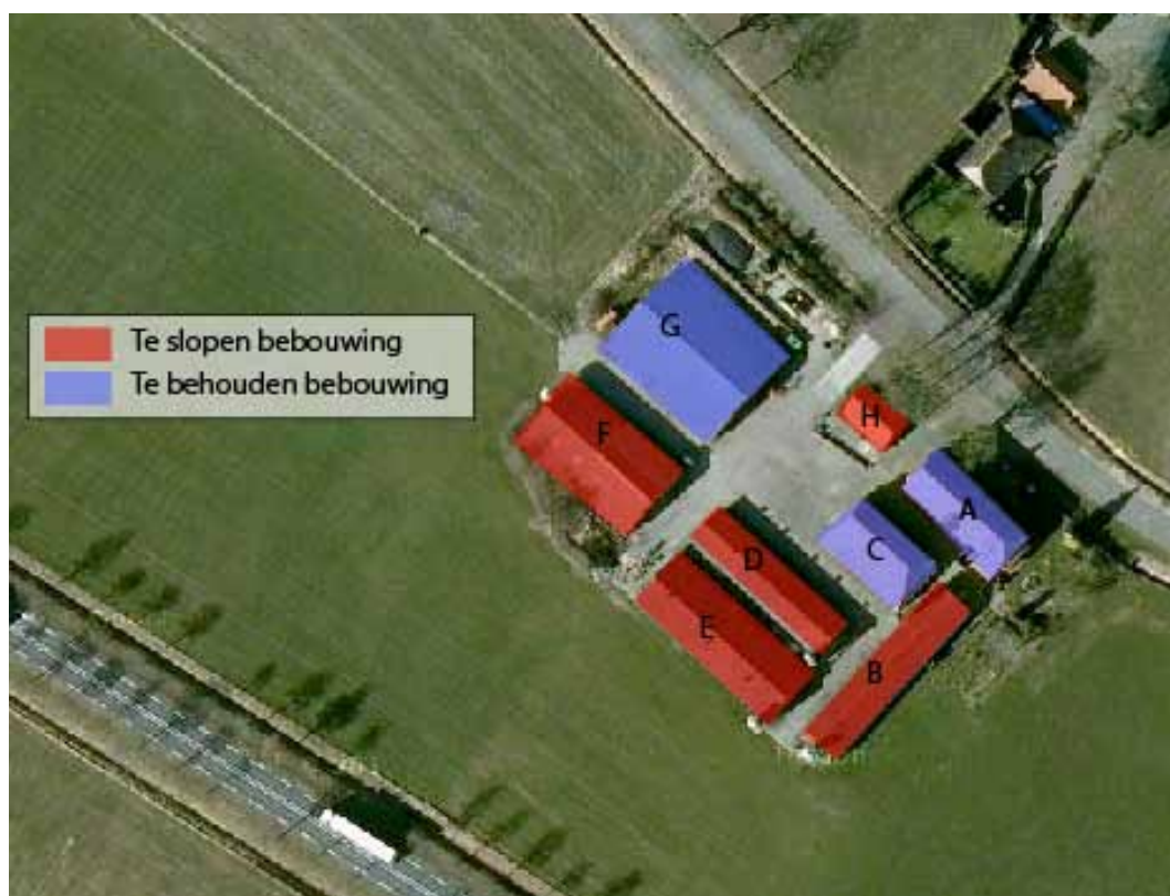
Afbeelding 10. Te slopen bebouwing Raalterweg
