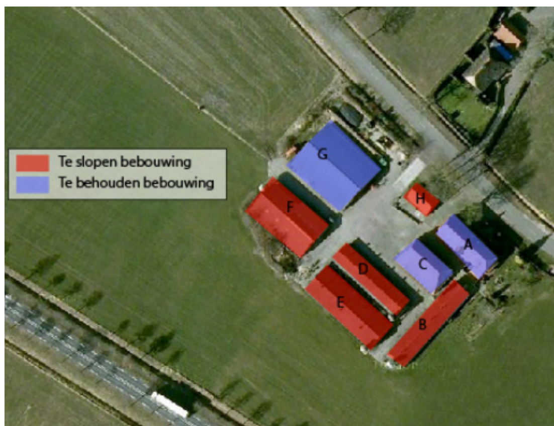
Figuur 6: luchtfoto plangebied, met te behouden en te slopen bebouwing (Bron: Google Earth)
