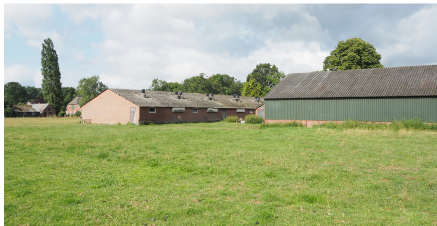
Zicht op te slopen schuren en locatie van nieuw aan te planten vogelbosje
