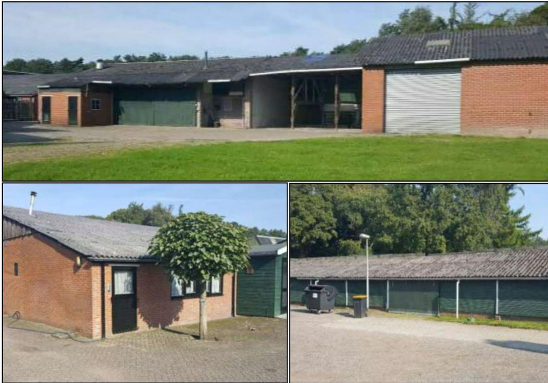
Afbeelding 2.2 Foto's te slopen bebouwing Biesterij 2/2a (Bron: Regtervoort Rentmeesters)
