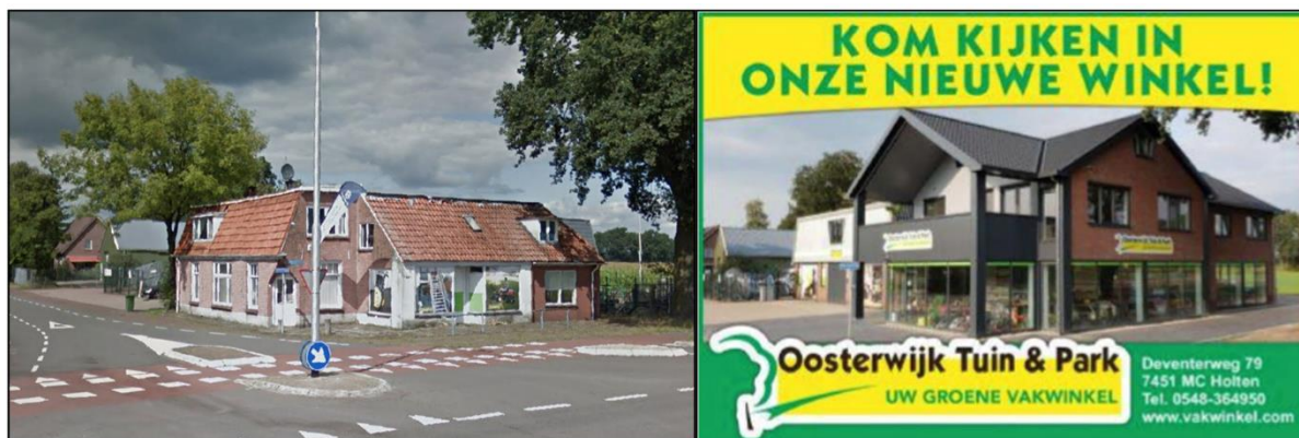
Afbeelding 2.2 Situatie voor (links) en na (rechts) na vernieuwing (Bron: Google streetview & initiatiefnemer)
