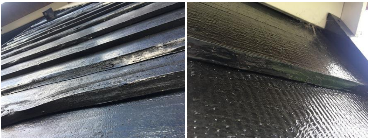
Detailopname van de houten betimmering.
