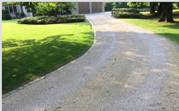
Aangestampt puin met laag van fijn grind
