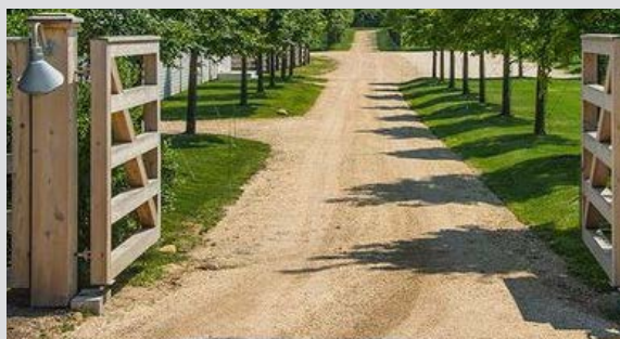
Aangestampt puin met deklaag van halfverharding
