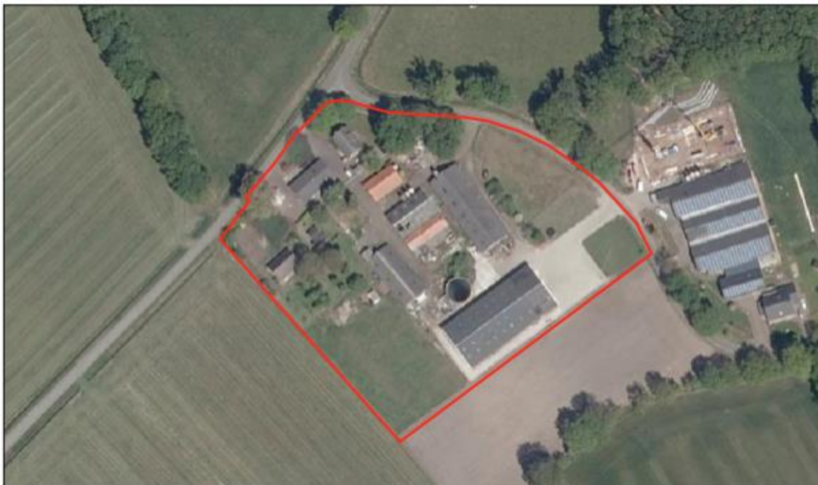
Afbeelding 2.1 Luchtfoto huidige situatie plangebied (Bron: Provincie Overijssel)
