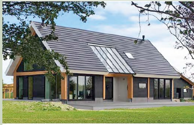
Woning met groot dakvlak en lage goot aanzet
