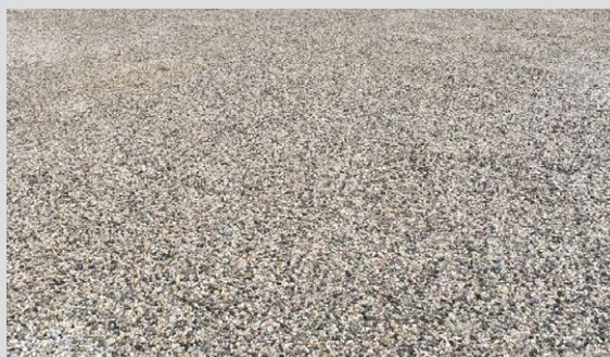
Halfverharding - grind op stabilisatieplaten
