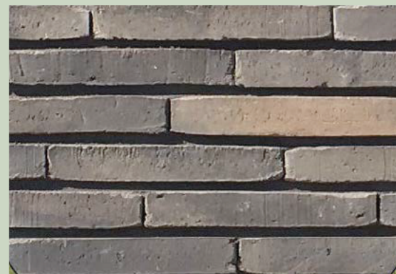
Donkere gevelsteen of stenen plint
