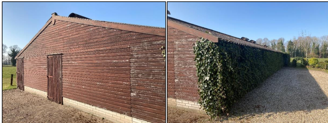
Figuur 2.13 (links): De te slopen houten schuur. De daklijst sluit goed aan; Figuur 2.14 (rechts): De noordzijde van de schuur, deze is begroeid door klimop. Het dak bestaat uit golfplaten.
