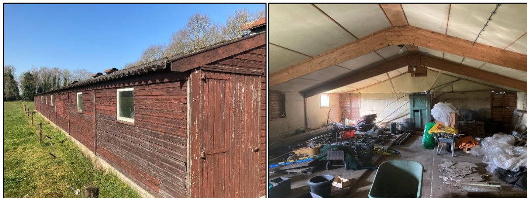
Figuur 2.15 (links): De zuidzijde van de houten schuur, ook deze zijde lijkt nog in goede staat te verkeren; Figuur 2.16 (rechts): De binnenkant van de schuur.
