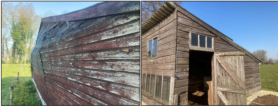
Figuur 2.16 (links): De westelijke zijde van de schuur, deze is in zeer slechte staat van onderhoud, vermoedelijk door rotting (vocht). Het geheel wordt met kippengaas afgesloten en bij elkaar gehouden; Figuur 2.17 (rechts): De tweede schuur op het terrein die wordt gesloopt is een kippenhok, het dak bestaat uit golfplaten zonder isolatie.
