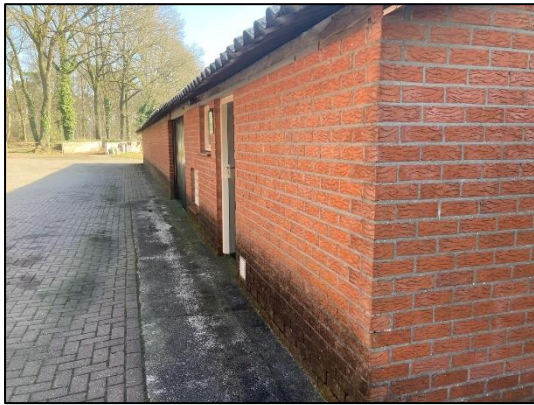
Figuur 2.6 (links): De noordoostzijde van de schuur; Figuur 2.7 (rechts): De noordzijde van de schuur, de daklijsten sluiten hier goed aan.
