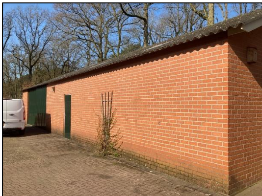
Figuur 2.11 (links): De oostelijke muur van de schuur. De muur is gemetseld, maar bevat geen stootvoegen. Het dak bestaat uit golfplaten.
