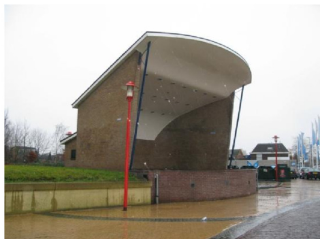
Afbeelding 5: Te slopen gebouw
