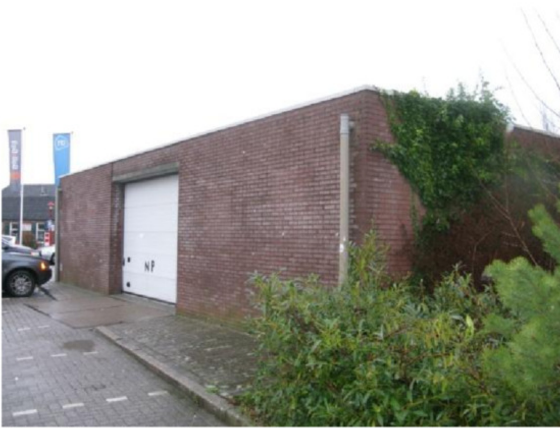
Afbeelding 6: te slopen gebouw dat dient als opslagruimte
