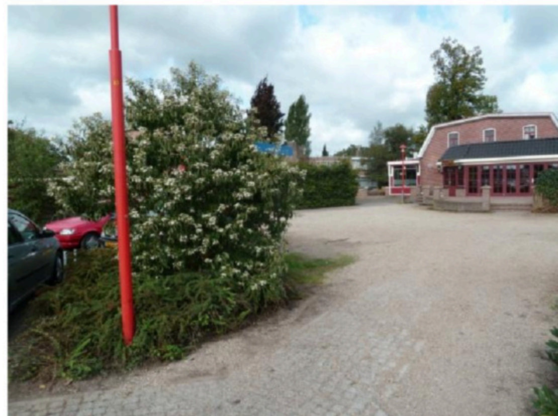
Afbeelding 4: de noordwest kant van het plangebied.
