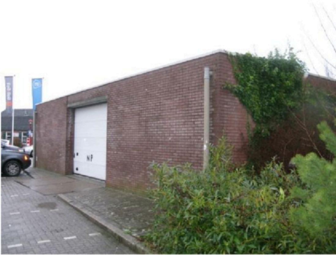
Afbeelding 6: te slopen gebouw dat dient als opslagruimte
