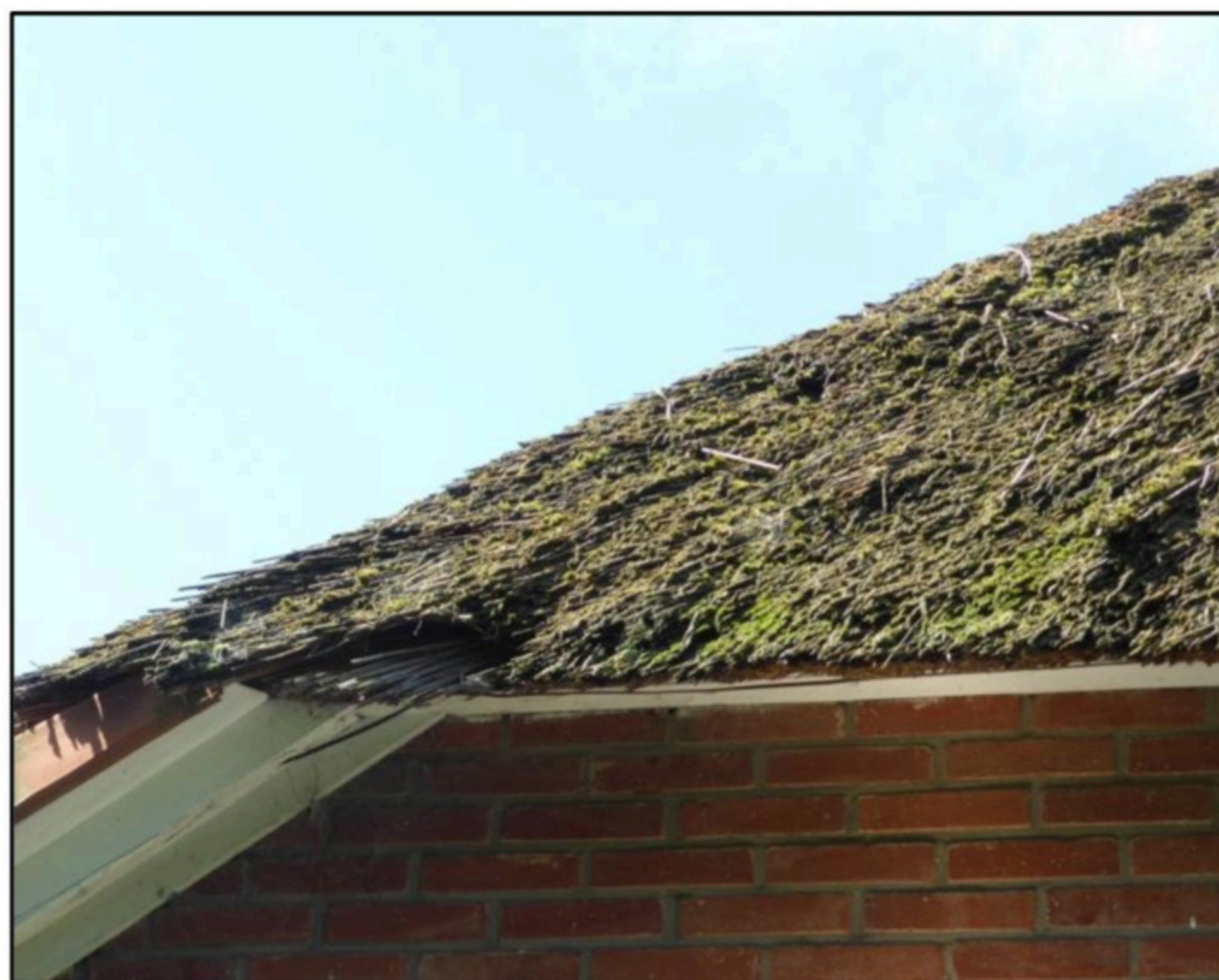
Afbeelding 7: het dak is in een erg slechte staat
