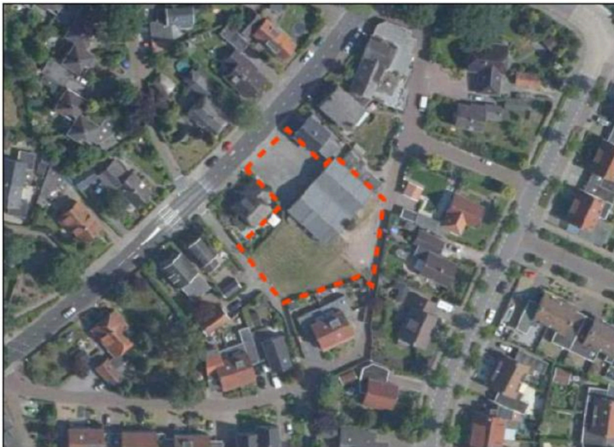
Afbeelding 2.2 Luchtfoto huidige situatie plangebied (Bron: Palazzo)
