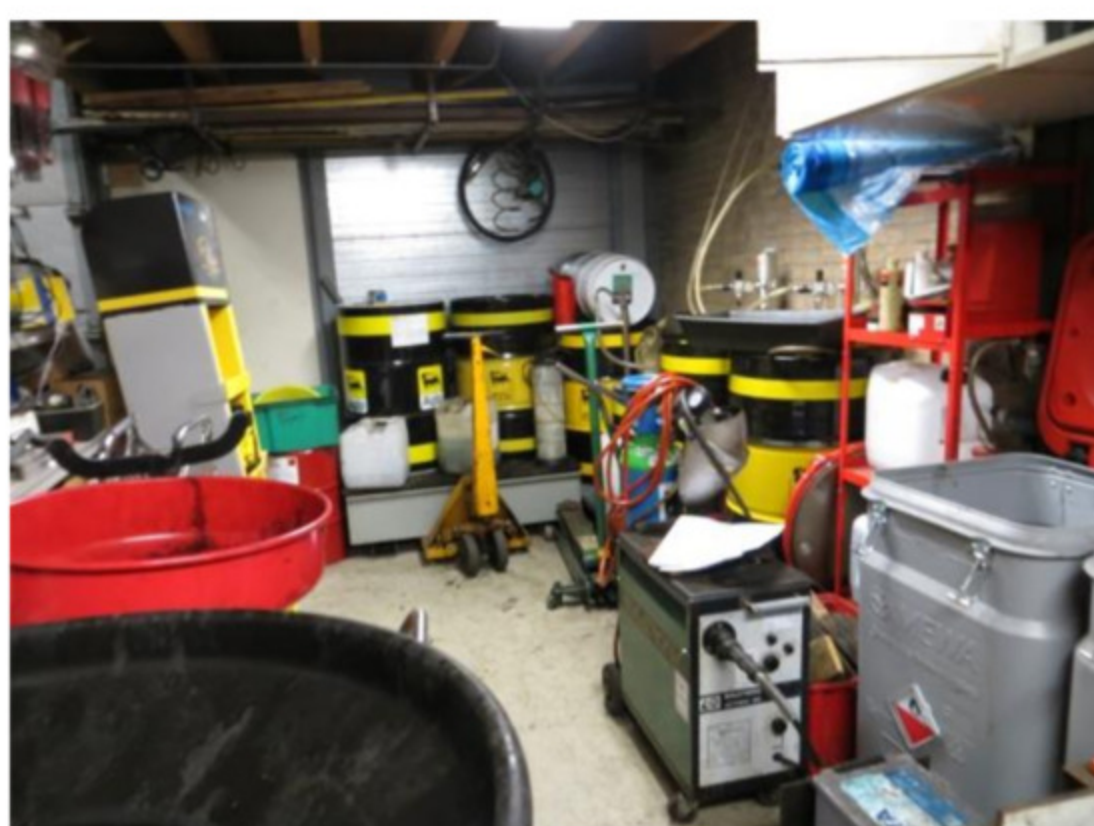
foto 5: Magazijn, opslag van afgewerkte olie in vaten op lekbak
