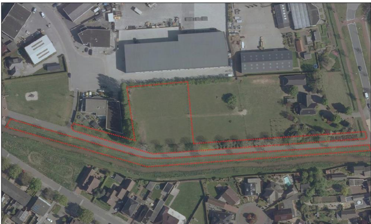
Figuur 2.1 Luchtfoto ligging plangebied (Bron: Atlas Overijssel)
