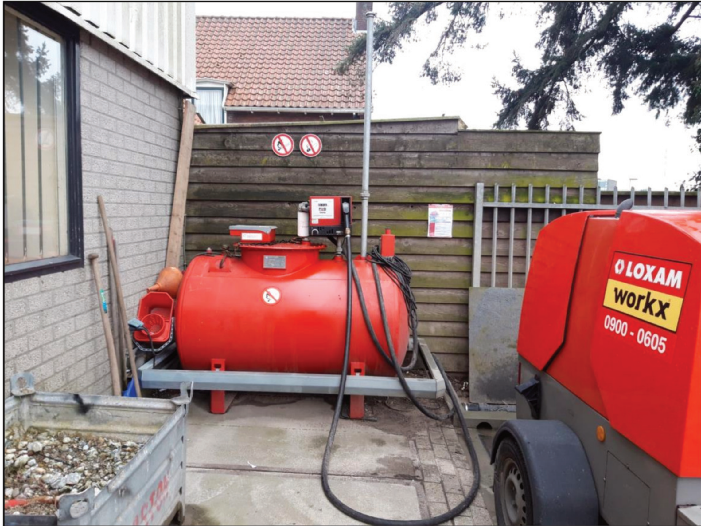
figuur 2: Foto van de bovengrondse dieselopslagtank naast de wasplaats (foto in zuidelijke richting)
