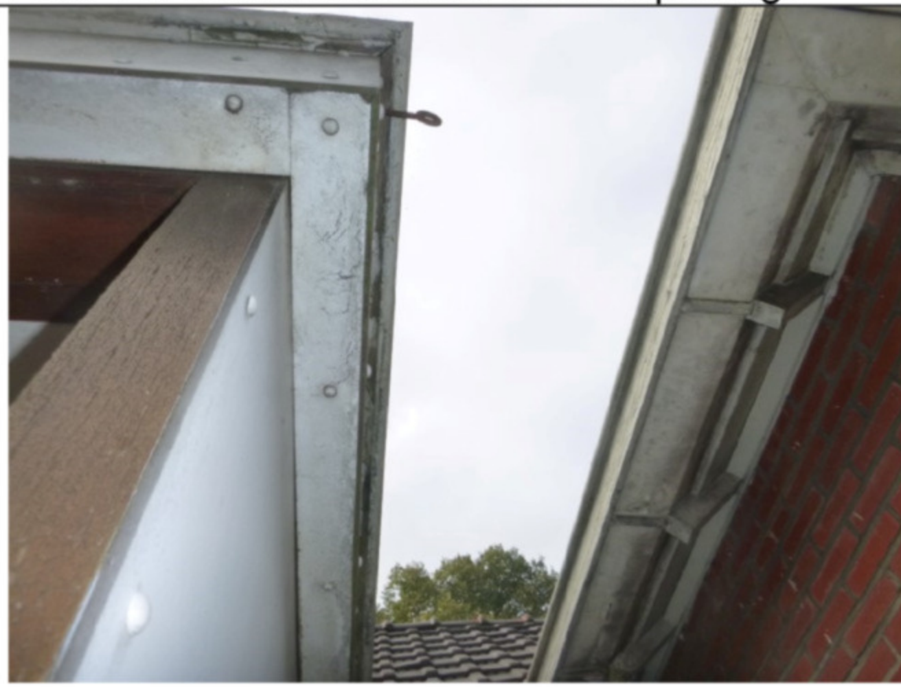
Foto 16: trespa beplating langs dakkapellen.
