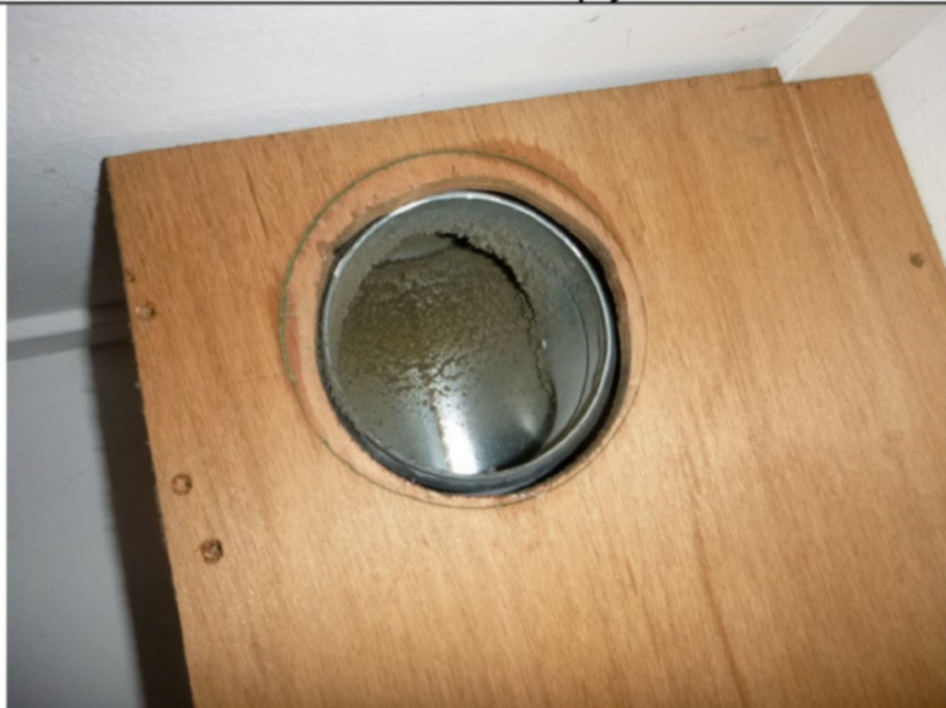
Foto 13: onderzoek bij ventilatiebuizen.
