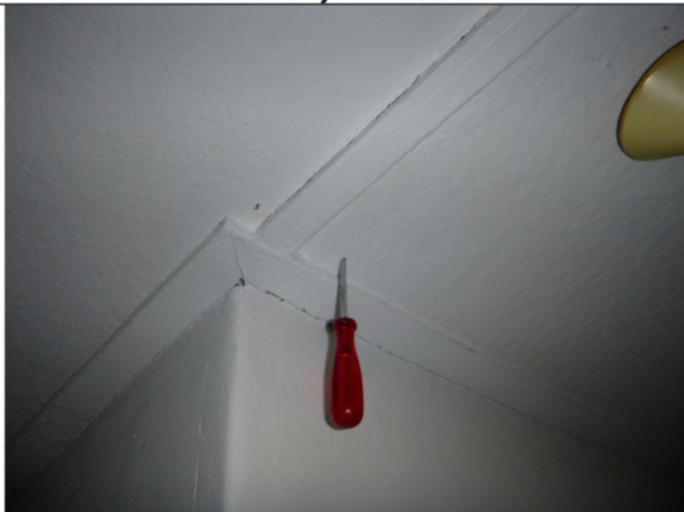
Foto 15: onderzoek naar plafondbeplating.
