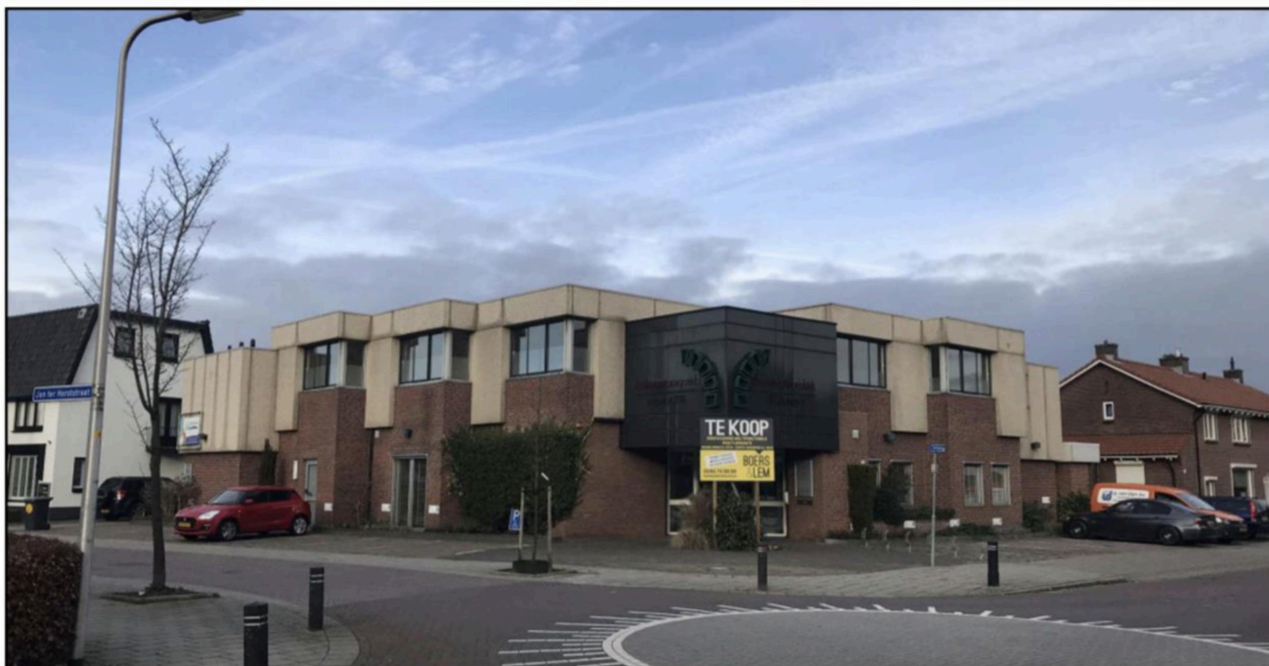
Afbeelding 2.2 Huidige situatie perceel met het pand (Bron: Google Streetview)
