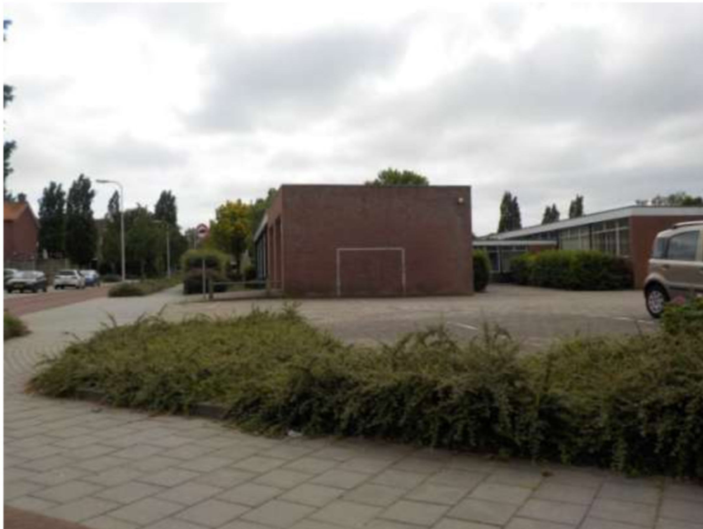
Afbeelding 20: Impressie van de onderzoekslocatie Willem Alexanderschool. Foto richting het noorden.
