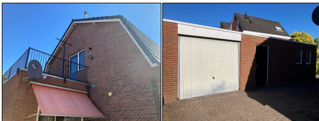
Figuur 2.5 (links): Achteraanzicht van de woning; Figuur 2.6 (rechts): Impressie van het bijgebouw.
