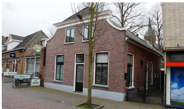
Panden die het historisch karakter van de Enterstraat ondersteunen
